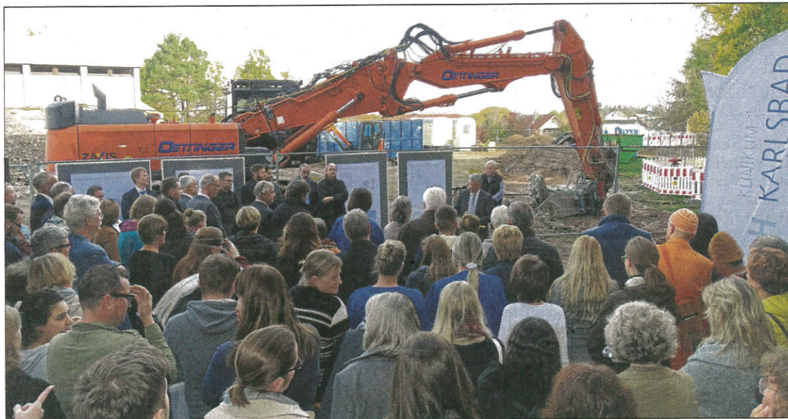
DIE FLÄCHE FÜR DEN NEUBAU am SRH-Standort Karlsbad soll bald freigeräumt sein. Anlässlich des symbolischen Spatenstichs sprach vor vielen Mitarbeitern auch Kliniken-Geschäftsführer Werner Stalla. Foto: rob
